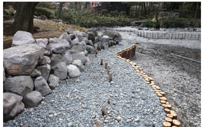
図9 西池 護岸工事の様子(向かって左の杭が旧護岸) 浅草寺提供
